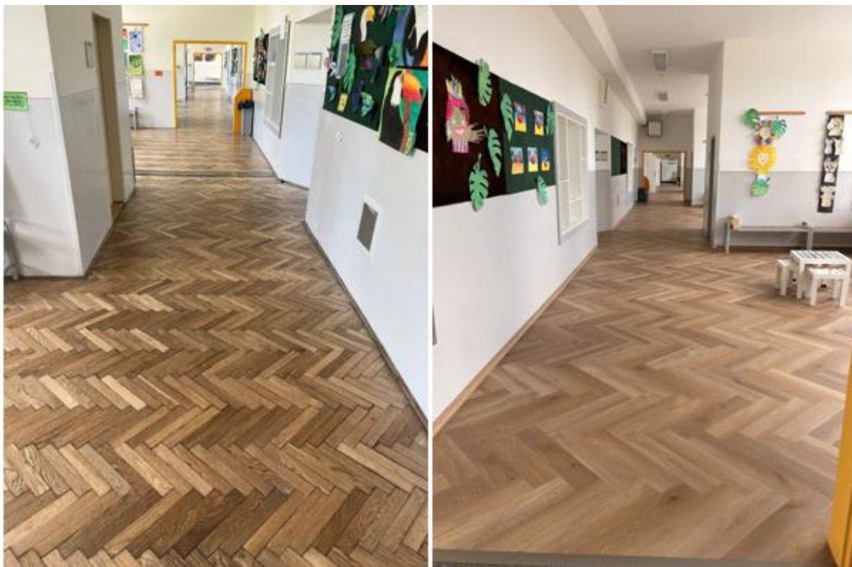
Prázdninová rekonstrukce podlahy v horní budově školy
